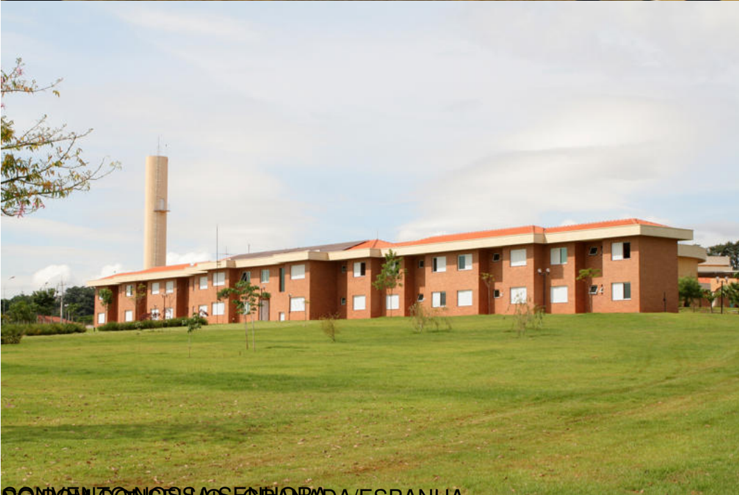
CONVENTO NOSSA SENHORA DO ROSÁRIO - SÃO PAULO/ESPANHA
